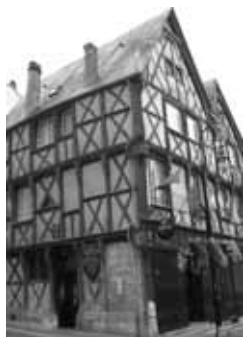
Maison à pans de bois © Philippe Savouret.
