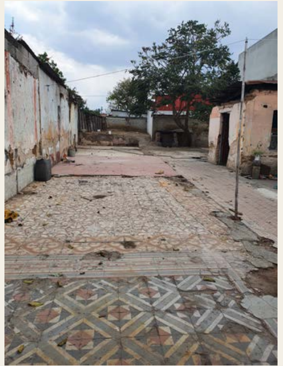
Ci-dessus : vue de l'entrée de la maison, vers l'emplacement du jardin au fond. Ci-dessous : façade de la maison
